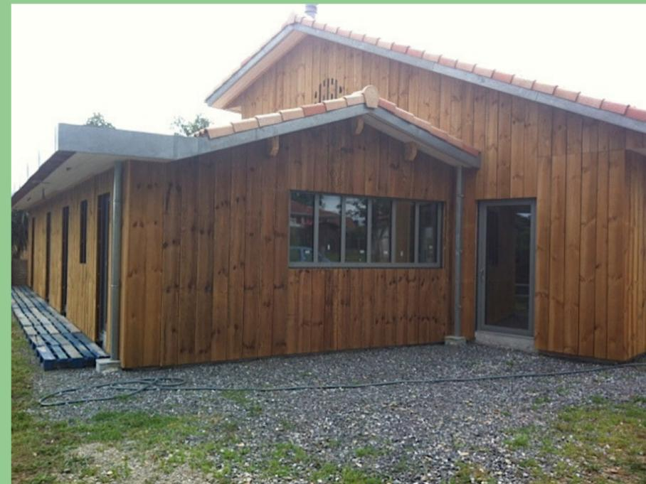
Isolation extérieure avec ouate et pin des Landes, VMC double Flux, lambris peuplier, terre, chaux, triple vitrage bois /alu
