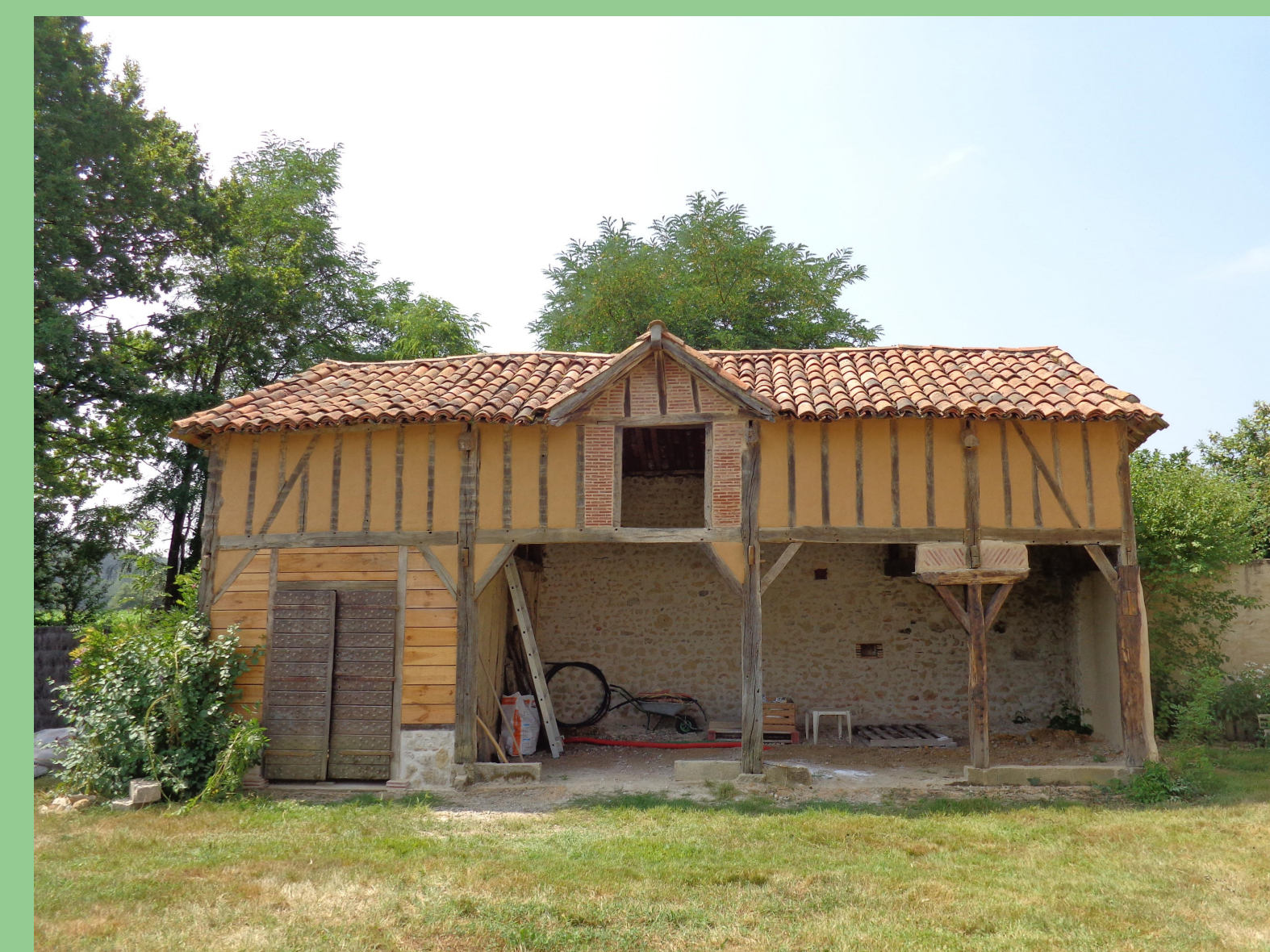
Enduits terre et chaux
