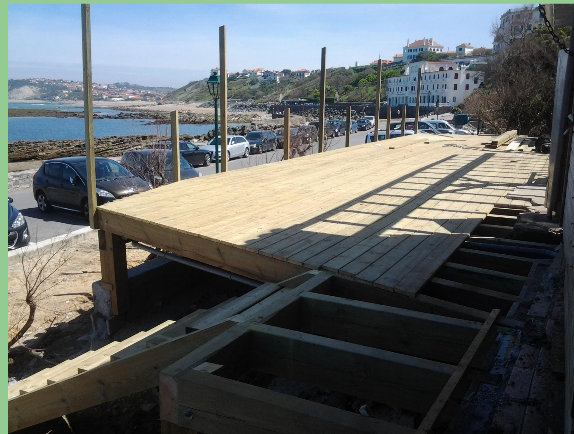
Terrasse extérieure avec escalier d'accès
