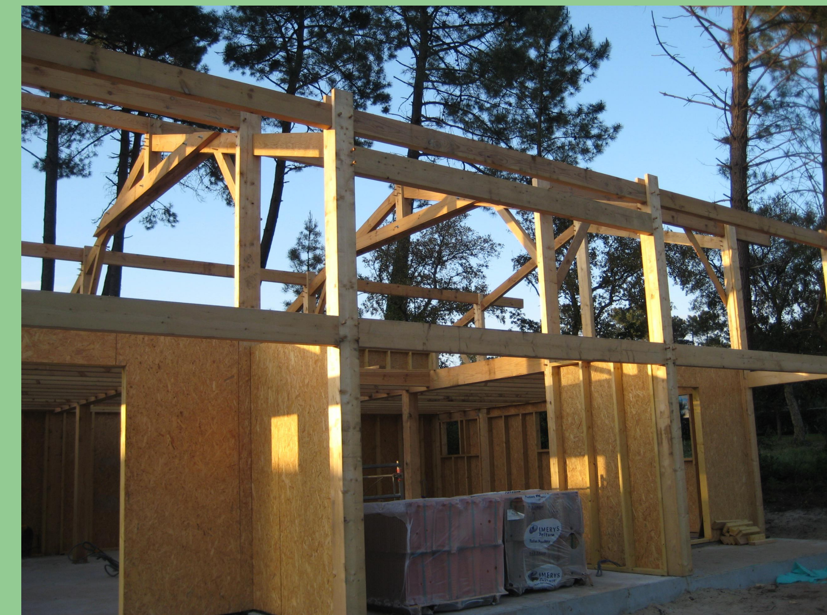
Maison ossature bois poteaux poutres
