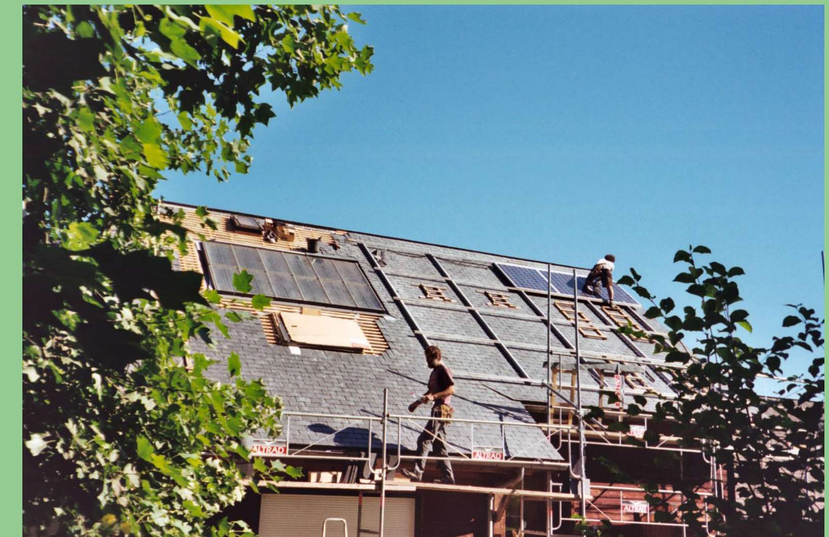
Dressage charpente, Isolation ouate de cellulose + laine de bois chanvre, couverture ardoise, Dépose/Pose de panneaux photovoltaïques
