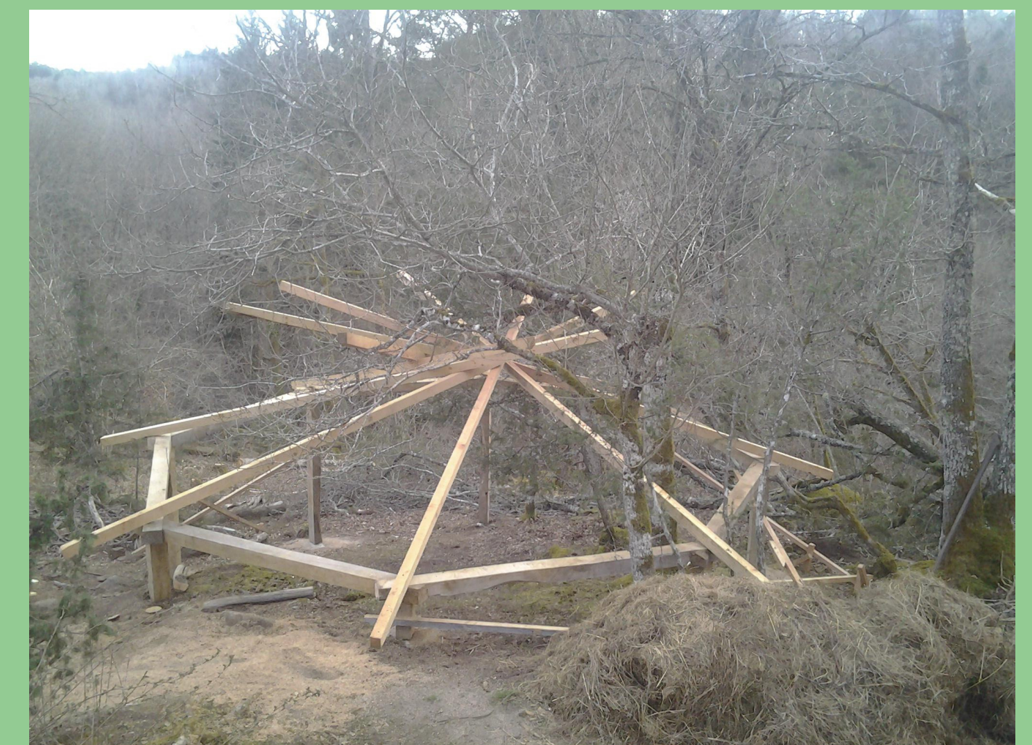
Charpente autoportée (dite réciproque)
