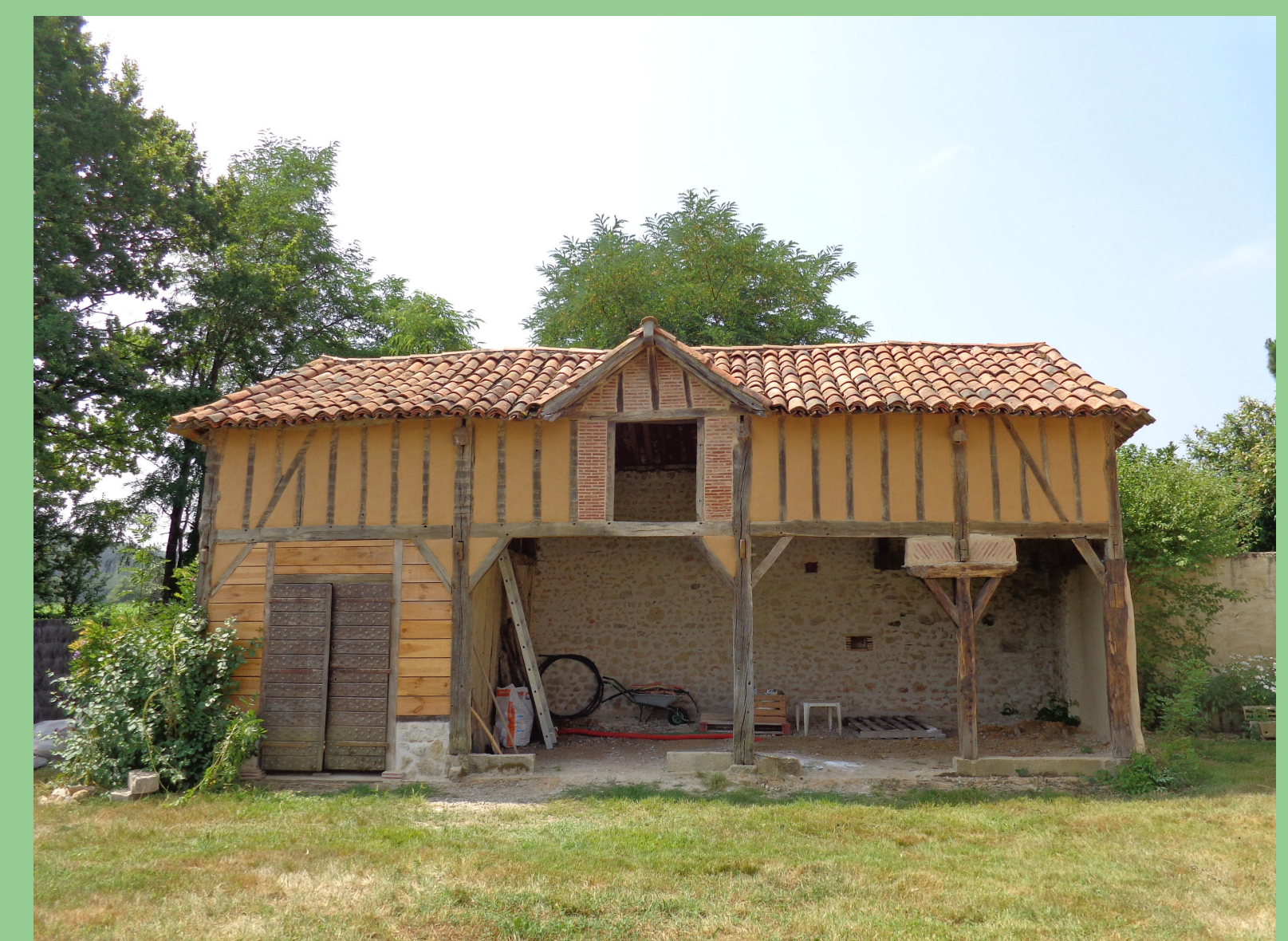
Enduits terre et chaux
