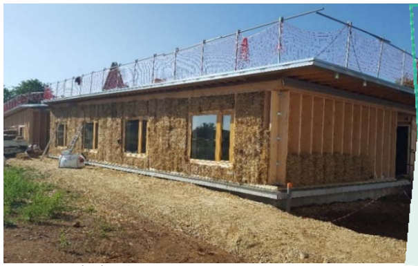
En cours de chantier
