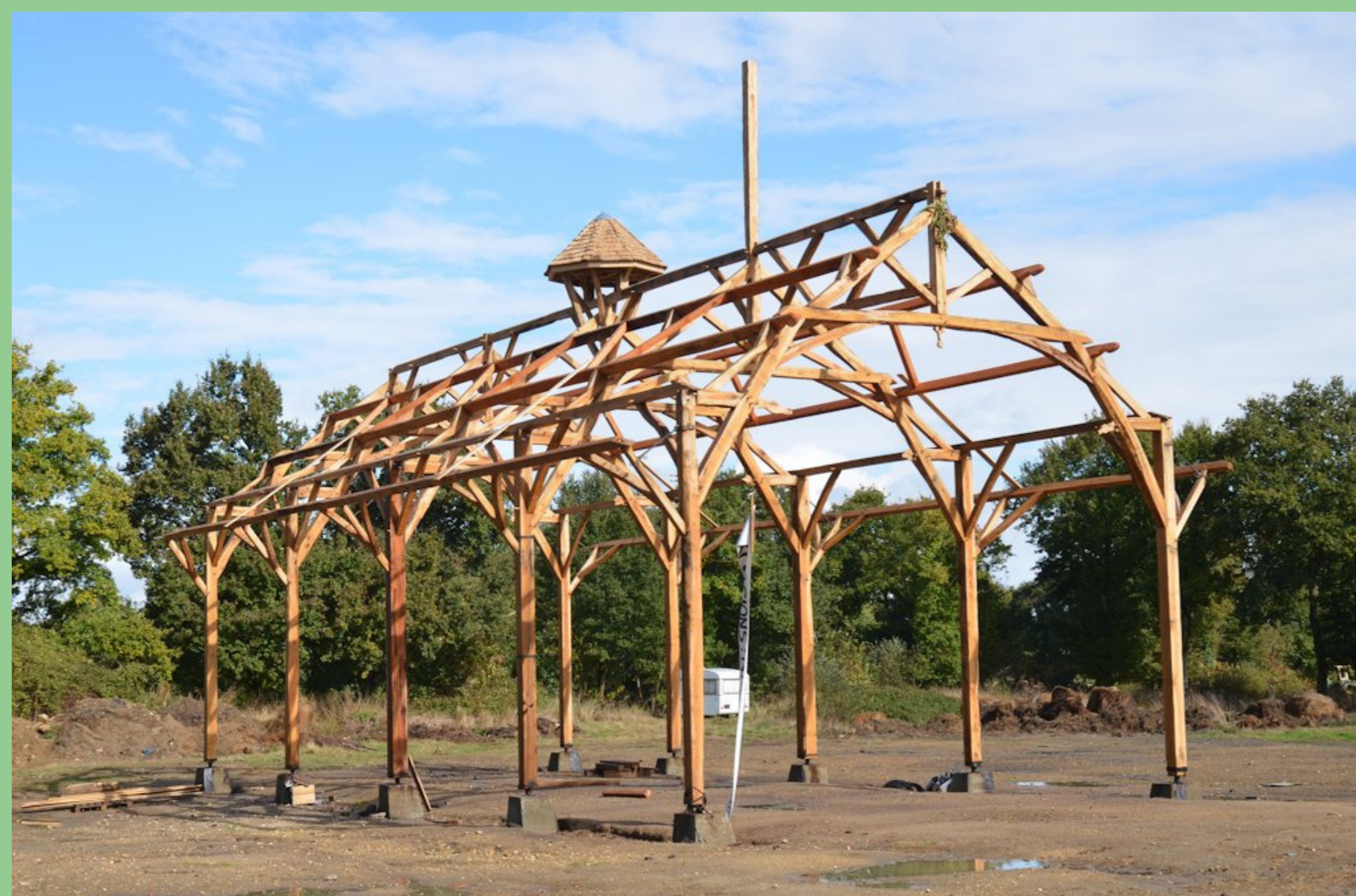
Hangar en charpente traditionnelle, taillé majoritairement à la main, réalisation collective à Notre-Dame-des-Landes (44)
