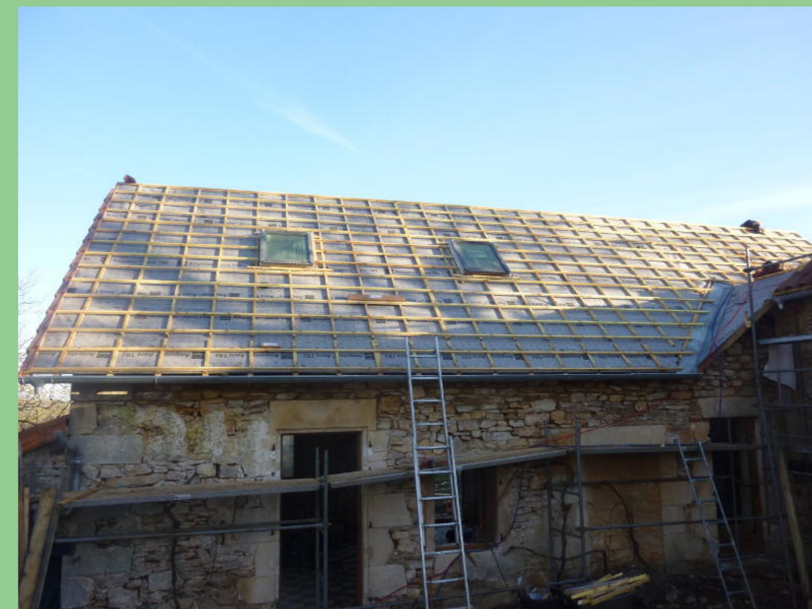
Rénovation toiture, pose de Velux à Cognac (24)
