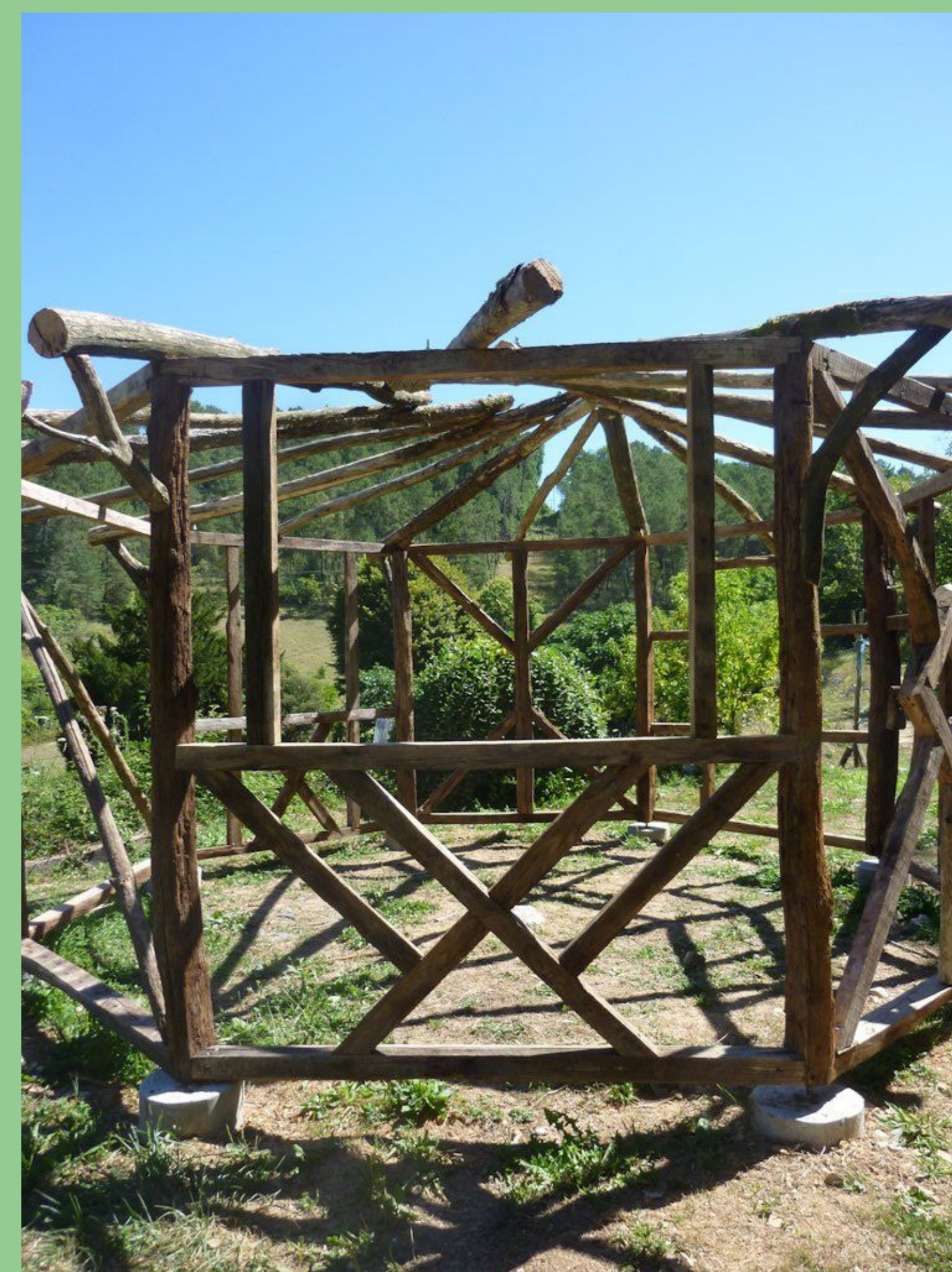
Cabane octogonale à pans de bois (colombages) et toiture en chevrons auto-portés
