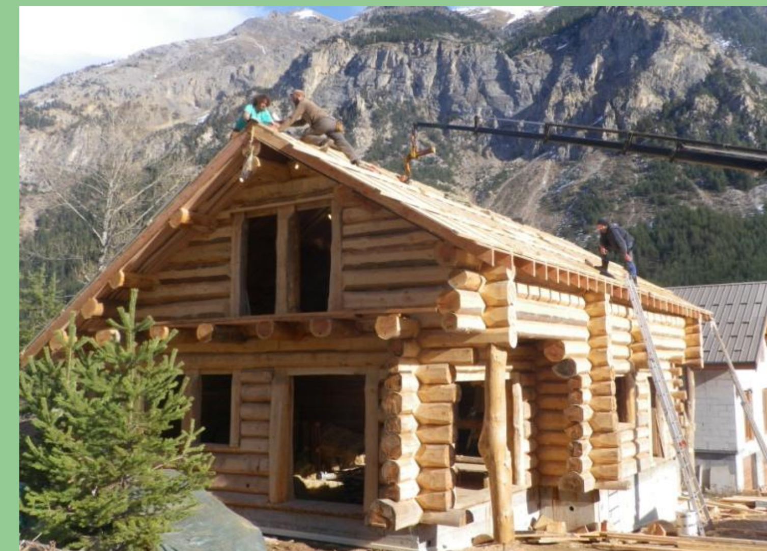
Chantier de remontage d'une fuste en douglas
