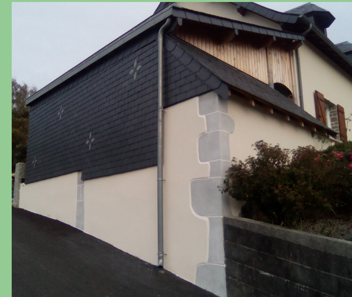
Réalisation d'un bardage en ardoise et en bois et d'une toiture raide sur un couvert existant
