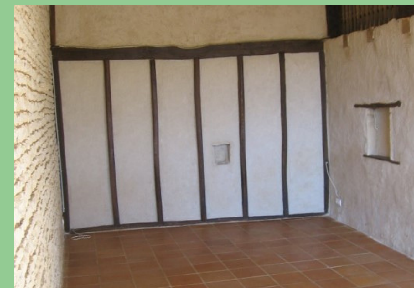
Sol: terre cuite, mur enduit chaux/chanvre
