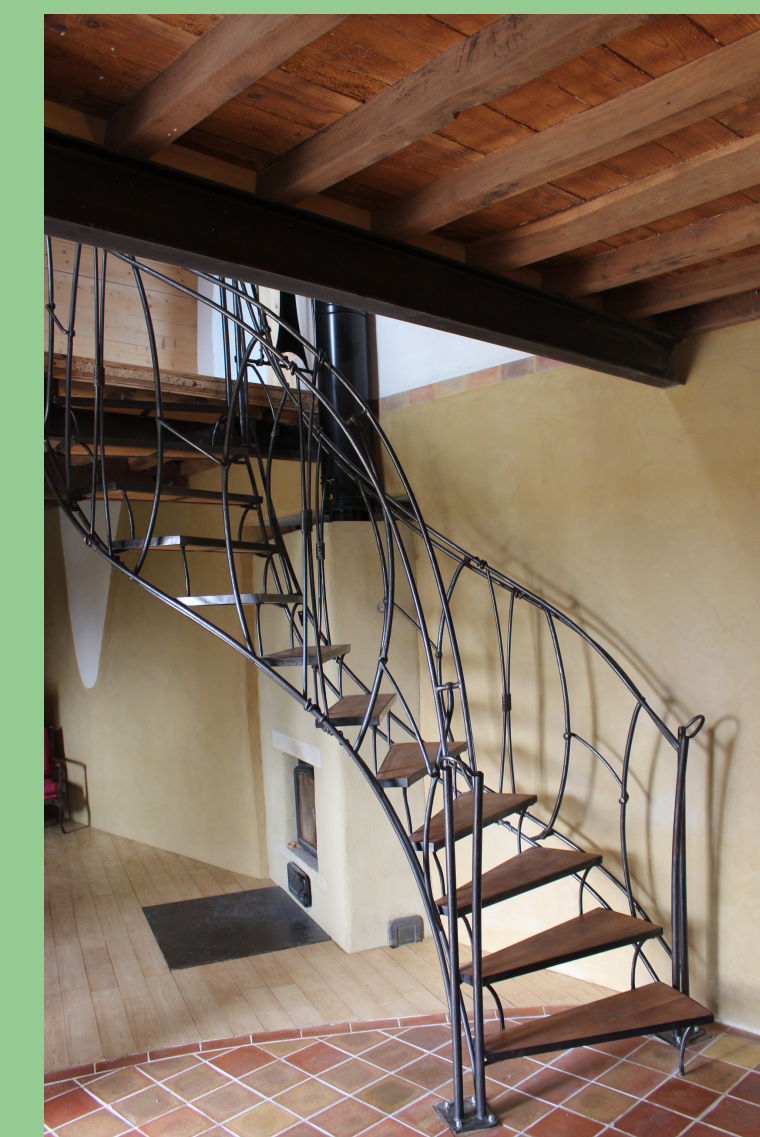
Sol: dalle chaux/pouzzolane finition terre cuite et parquet châtaigner, mur enduit terre et escalier acier pièce unique!
