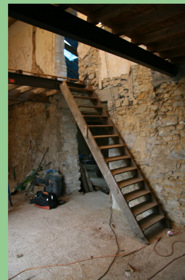
Etat initial: création d'une ouverture dans le mur de refend pour construction poêle de masse
