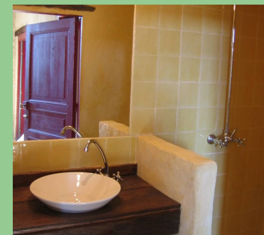
Salle de bain : récupération vieux plancher en chêne pour réaliser le plan recevant la vasque
