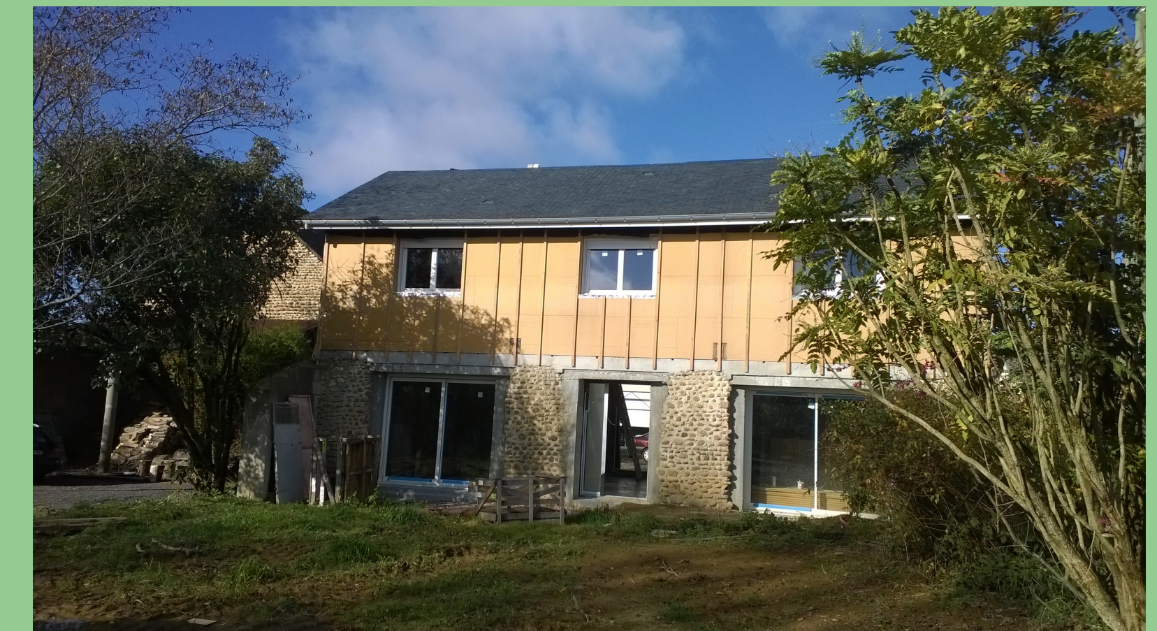
Réhabilitation d'une grange en habitation et surélévation ossature bois, isolation écologique et couverture en ardoise
