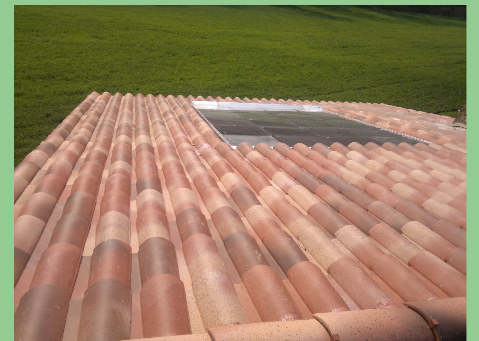
Réalisation d'une couverture en tuile avec mise en place de panneaux solaire
