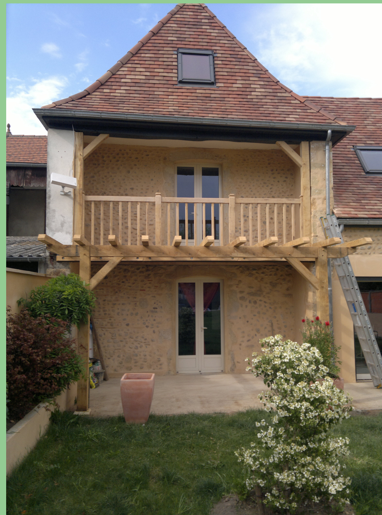
Création d'un balcon et d'une pergola en chêne
