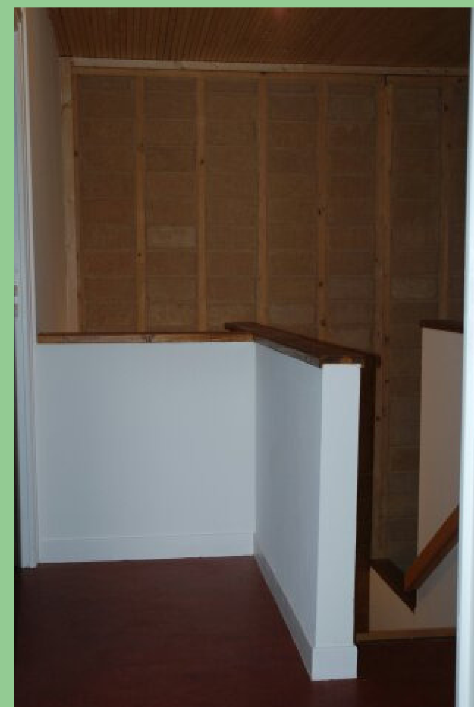
Plaquage Fermacell - Remplissage entre bois de briques de terre compressée
