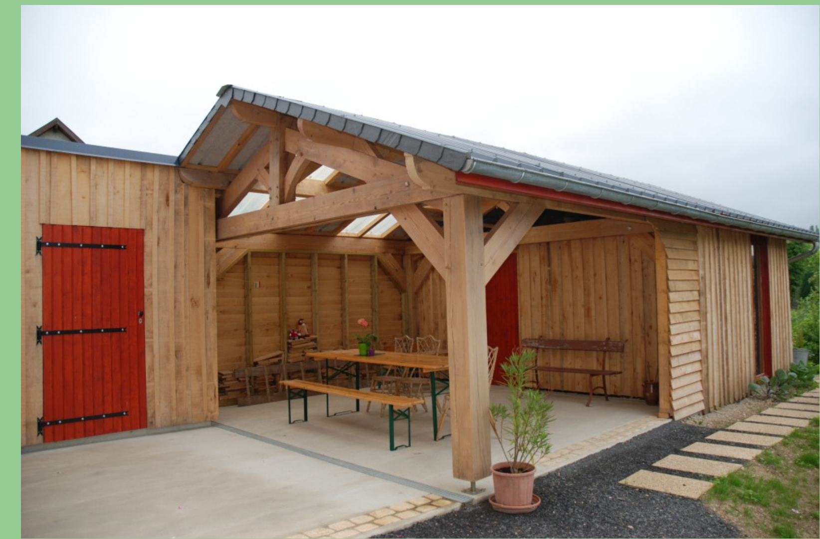
Charpente traditionnelle et bardage en bois local - Isolation saine
