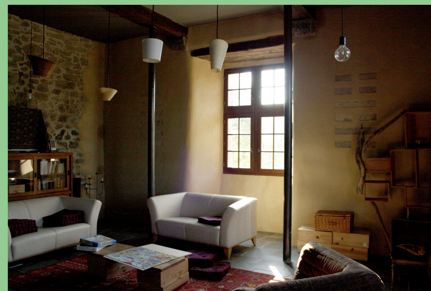
Enduits chaux chanvre projetés (300m 2 ) et enduits de finition terre (100m 2 ) Saint Esteben (64) - 2012
