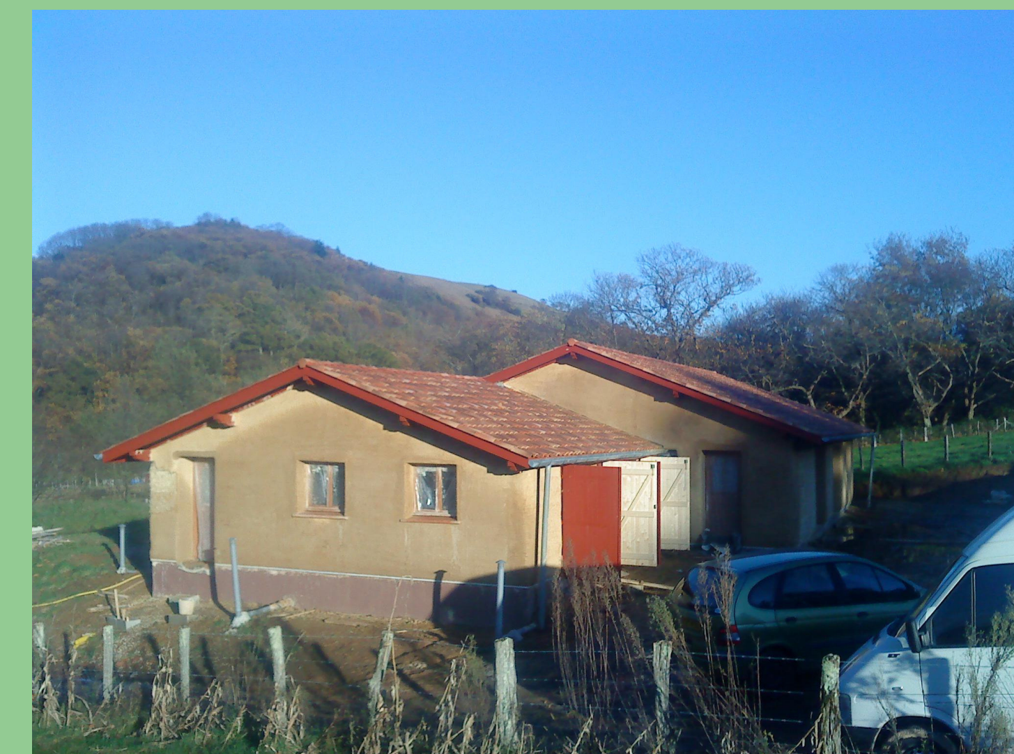
Implantation, fondations, mur de soubassement, vide sanitaire, dalle BA, isolation en botte de paille, enduits terre int/ext. Maison individuelle 190 m 2 . Macaye (64) - 2009
