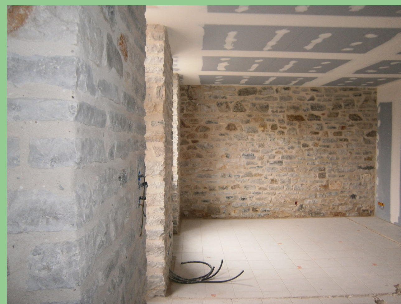
Rejointement de moellons à la chaux. Enduits chaux chanvre et enduits de finition chaux sable coloré Bayonne (64) - 2015
