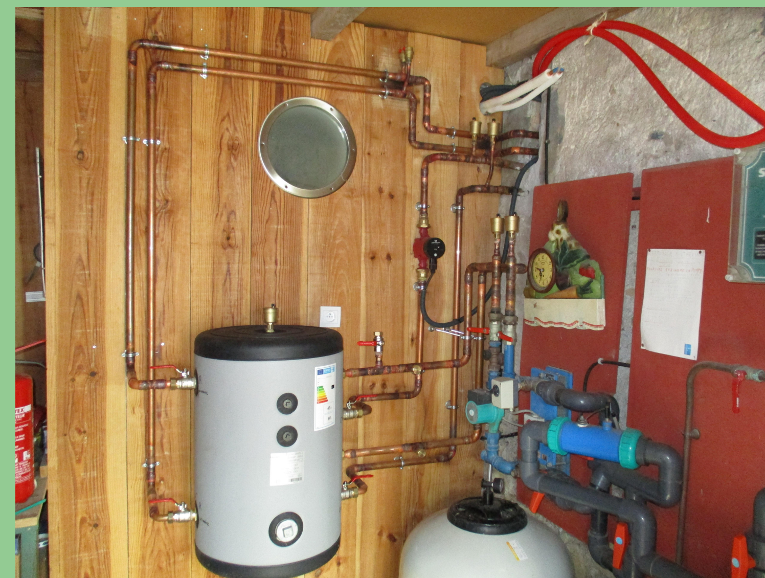
Ballon tampon - pompe à chaleur
