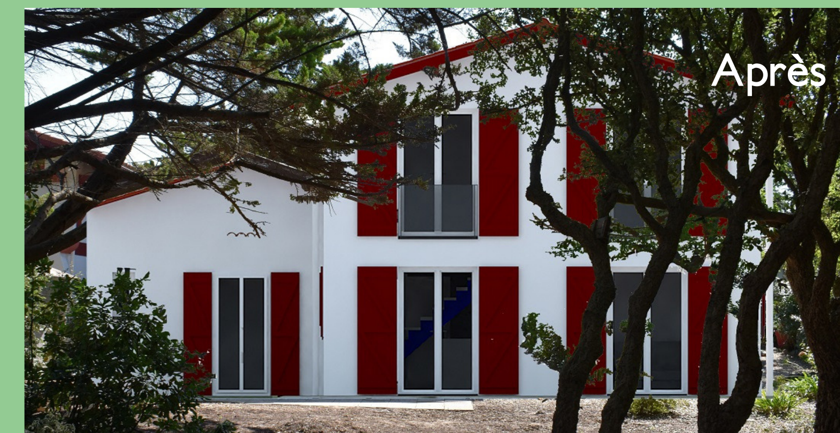
Projet de rénovation et d'extension : de l'idée au dossier de permis et mise en relation avec un maître d'oeuvre et des artisans – HOSSEGOR
