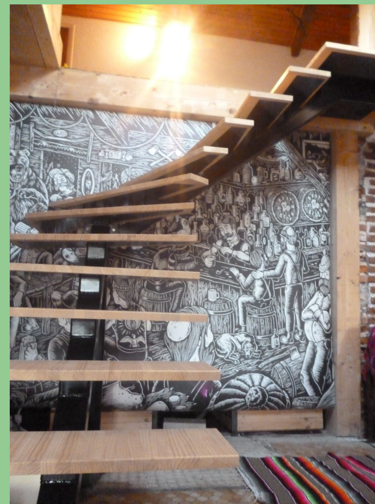
Escalier limon central en acier peint, marche en bois d'hévéa
